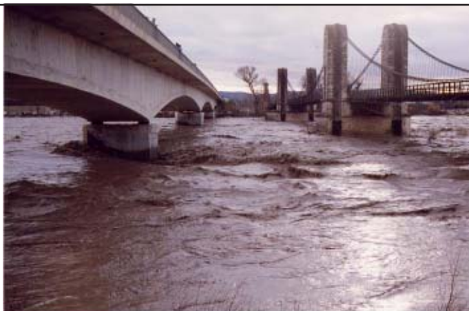
La Durance en crue au pont de Mallemort en janvier 1994
