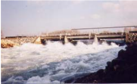
Le déversoir de Mallemort qui ouvre le canal EDF sur la Durance
